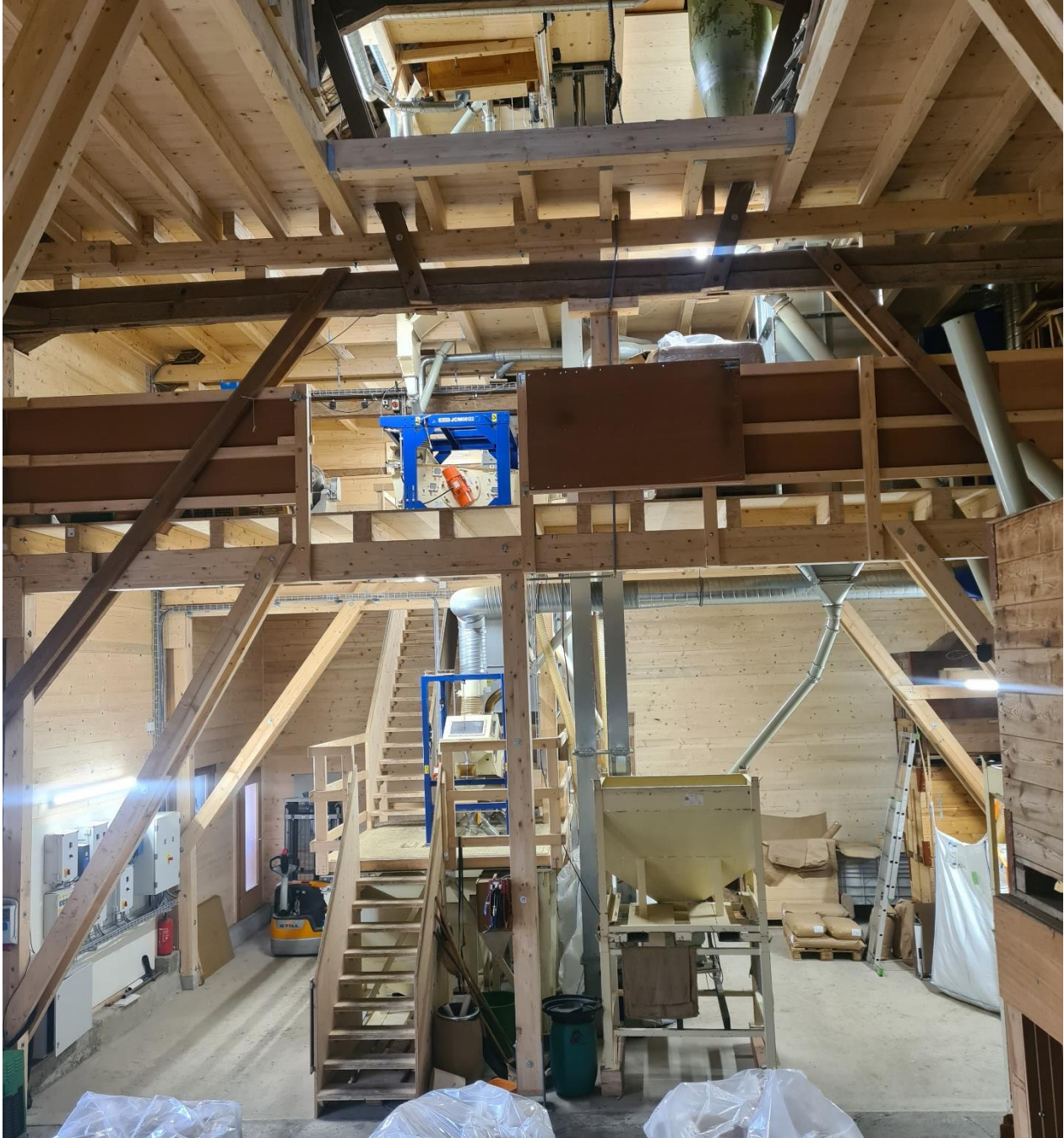
Der Umbau der alten Scheune und die Installation dieser Schälmaschine wurden mit einem Investitionskredit unterstützt. (Foto zVg)
